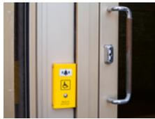
Des systèmes de communication ou d'ouverture entre 0,80m et 1m30
